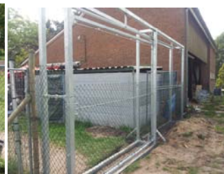
Grote schuifpoort geplaatst
