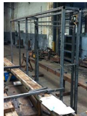
Grote schuifpoort in aanbouw
