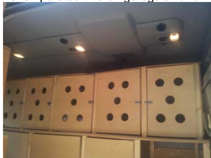
(airco unit en loop verlichting in het plafond.)
